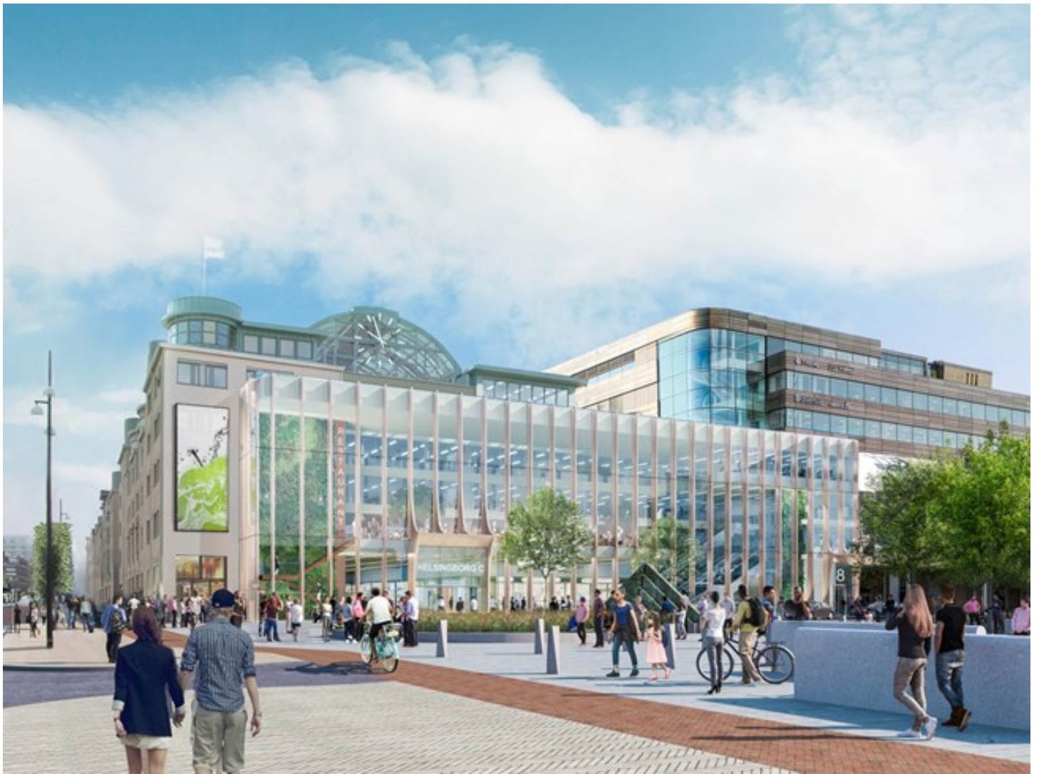
Moderniserat Knutpunkten blir Helsingborg C
